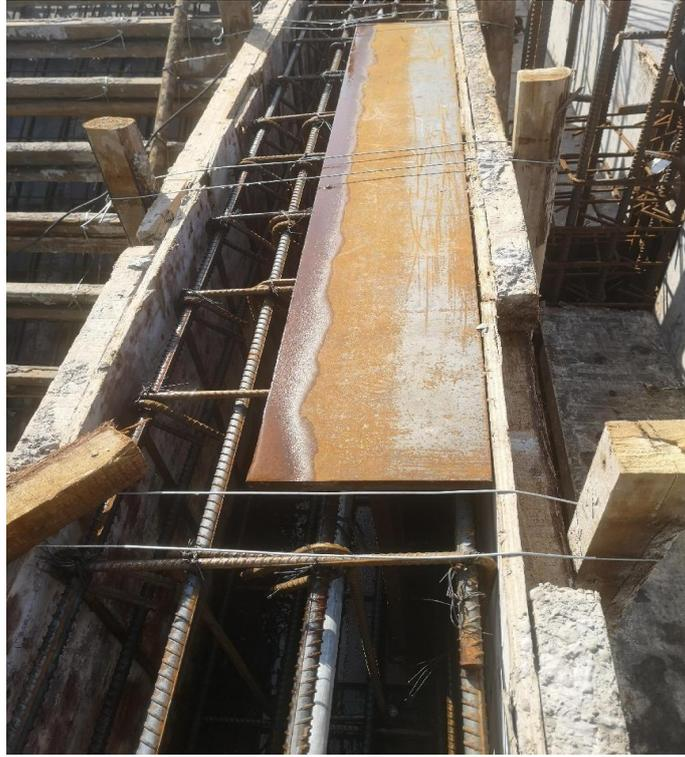
图 7 梁顶预埋件安装
